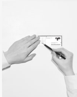
2. Bohrlöcher mit Schablone anzeichnen.
